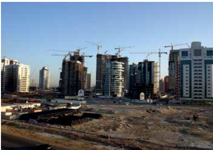
Dubai Stadt im Bau. Dubai under construction.
